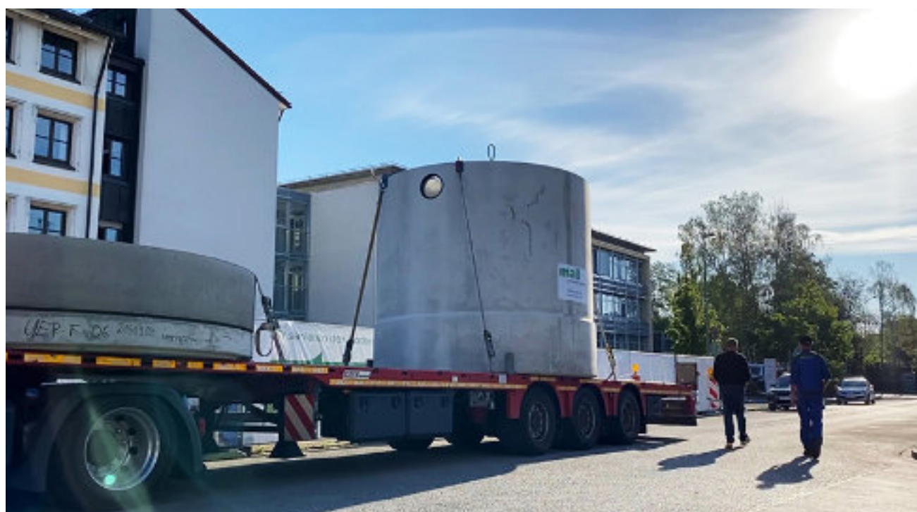
Bild: Die Sedimentationsanlage der Firma Mall aus Donaueschingen – transportiert vom 48-Tonner-Schwerlasttransporter
