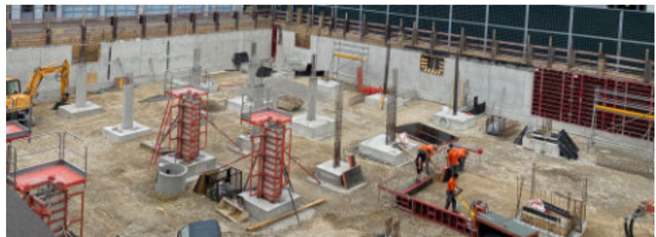
Bild: Ende September waren die Punktfundamente weitgehend fertig gestellt.
