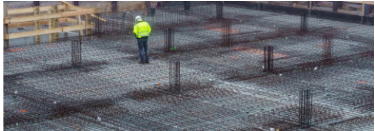
Bild: 10. November — die Bewehrungen für die Bodenplatte sind verlegt.
